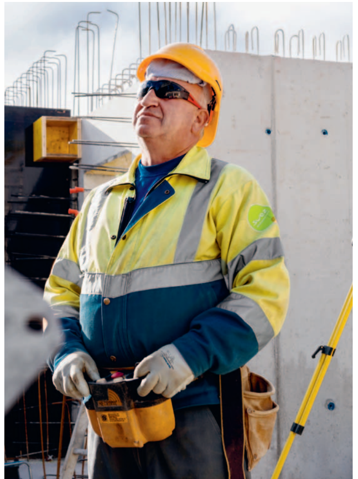
^ Kranführer auf der Baustelle.
