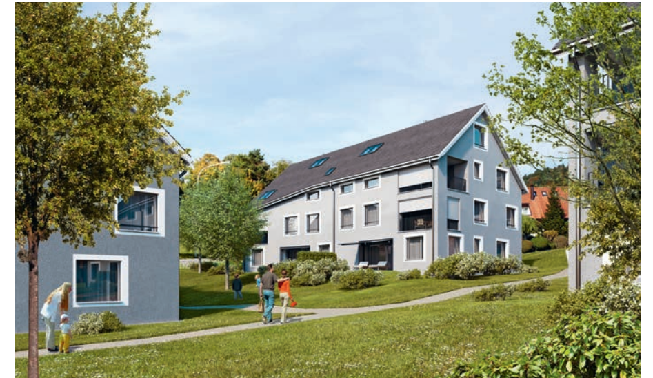
^ Unterengstringen | Visualisierungen Raumgleiter GmbH, Zürich
